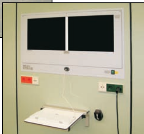
Visionneuse d'images digitales Xray avec 2 écrans encastrés
